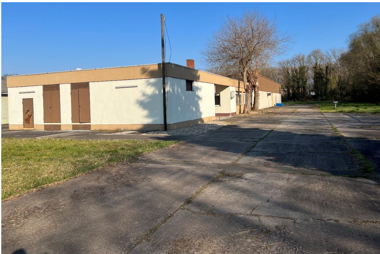
Foto 1: Blick auf den Eingangsbereich (Quelle: Ingenieurbüro Zillinger, März 2022)
