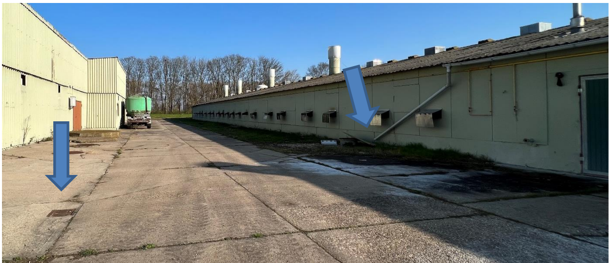
Foto 5: Flächenversiegelung zwischen den vorhandenen Hallen mit Kennzeichnung eines Straßenablaufes und einer Falleitung (Quelle: Ingenieurbüro Zillinger, März 2022)
