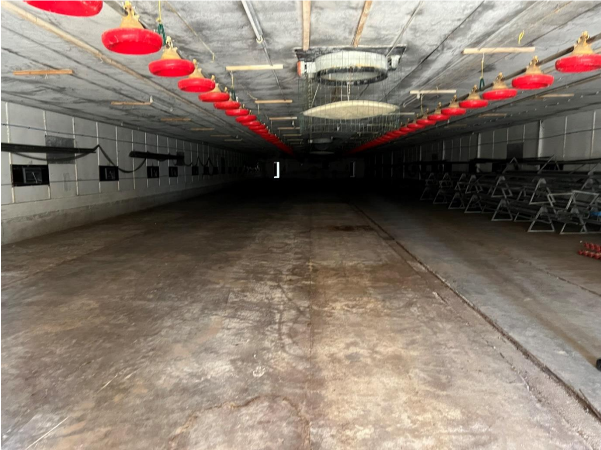
Foto 4: Halle von innen (Quelle: Ingenieurbüro Zillinger, März 2022)
