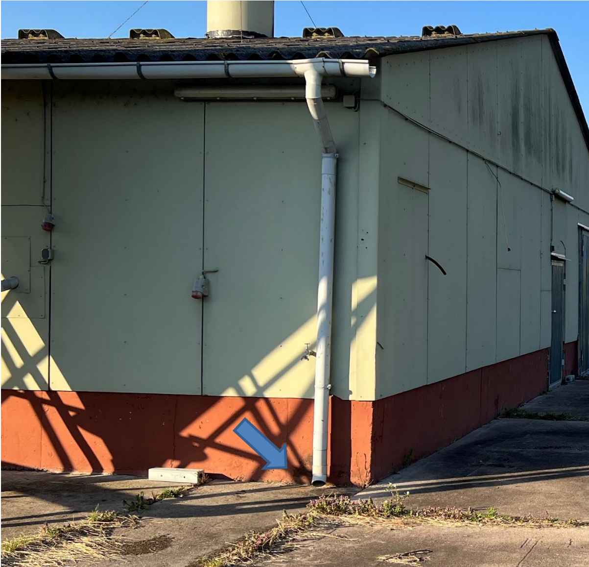
Foto 6: Falleitung einer Halle (Quelle: Ingenieurbüro Zillinger, März 2022)
